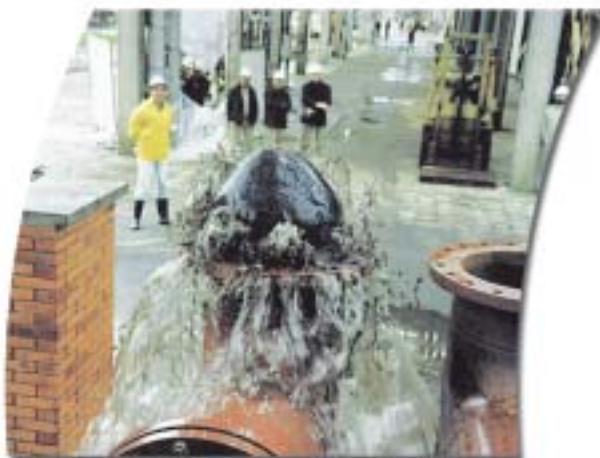
Saída do Pig Após o Percurso
