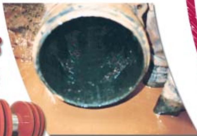
Tubulação Após a Limpeza
