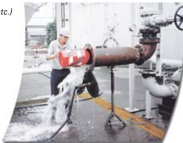
Instalação do Pig no Lançador
